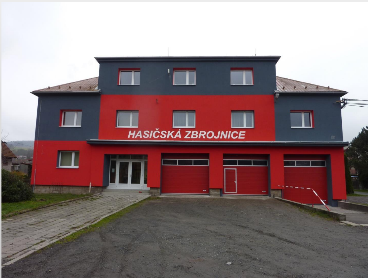
Rekonstrukce OD – HZS Jablůnka
